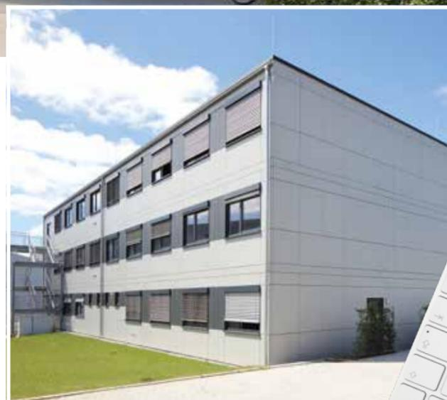
Die Optik des neuen Projektgebäudes ist perfekt auf die Nachbargebäude am Daimler-Standort in Sindelfingen abgestimmt. Für die Fassade wurden glattflächige, kolorierte Fassadenplatten gewählt. Innen ist das Gebäude zweckmäßig ausgestattet und entspricht den Premium-Anforderungen der Daimler AG bestens.
