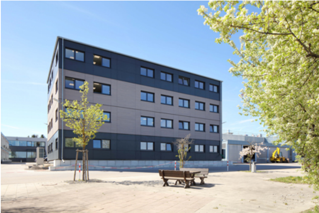
Das neue Bürogebäude in Modulbauweise am Standort Schopfloch.
