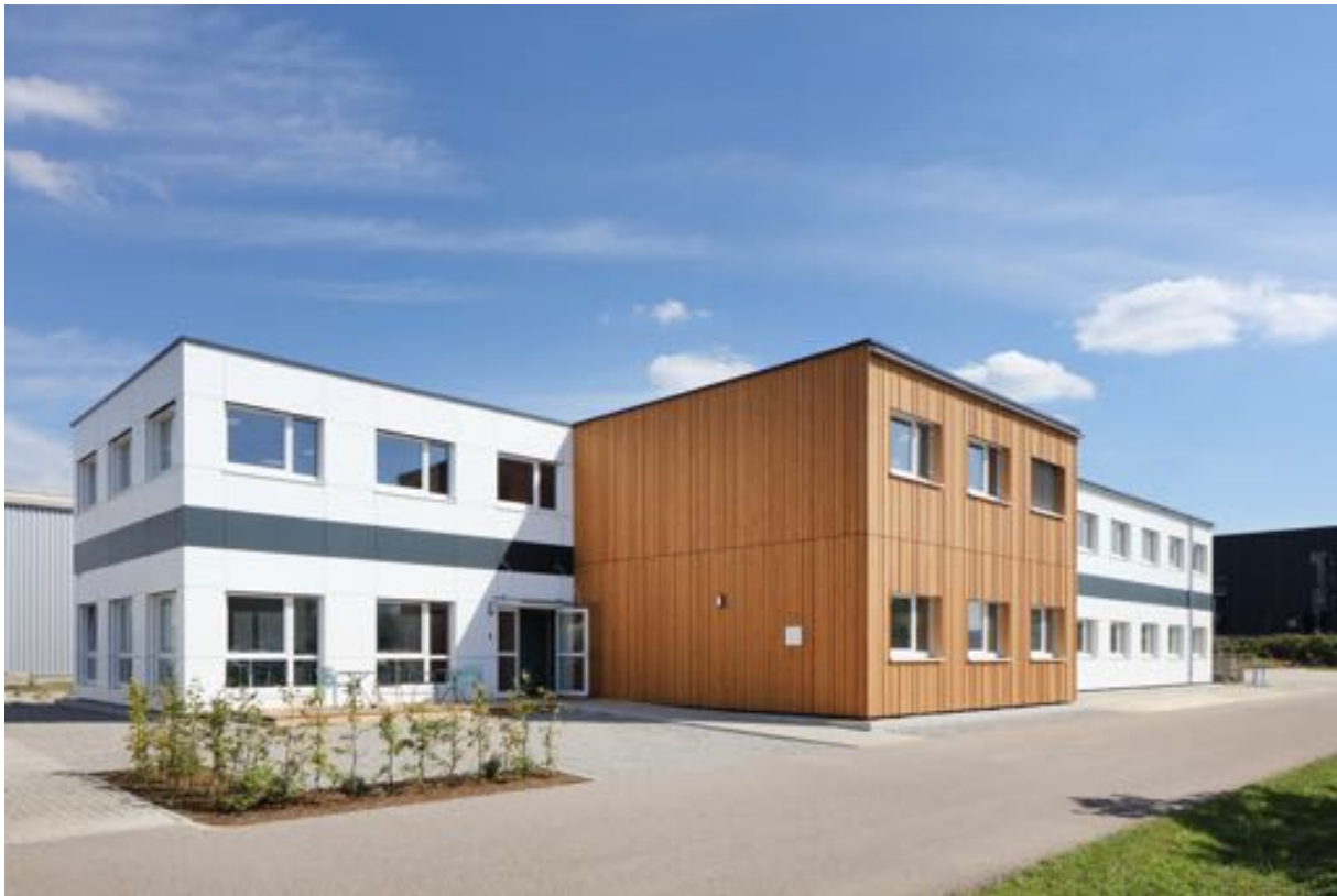
Bild 1: Fassade mit 2-farbigen HPL-Colorplatten und Lärche-Schalung. Durch die unterschiedlichen Höhen der Leisten entsteht eine abwechslungsreiche Oberflächenstruktur in 3D-Optik.
