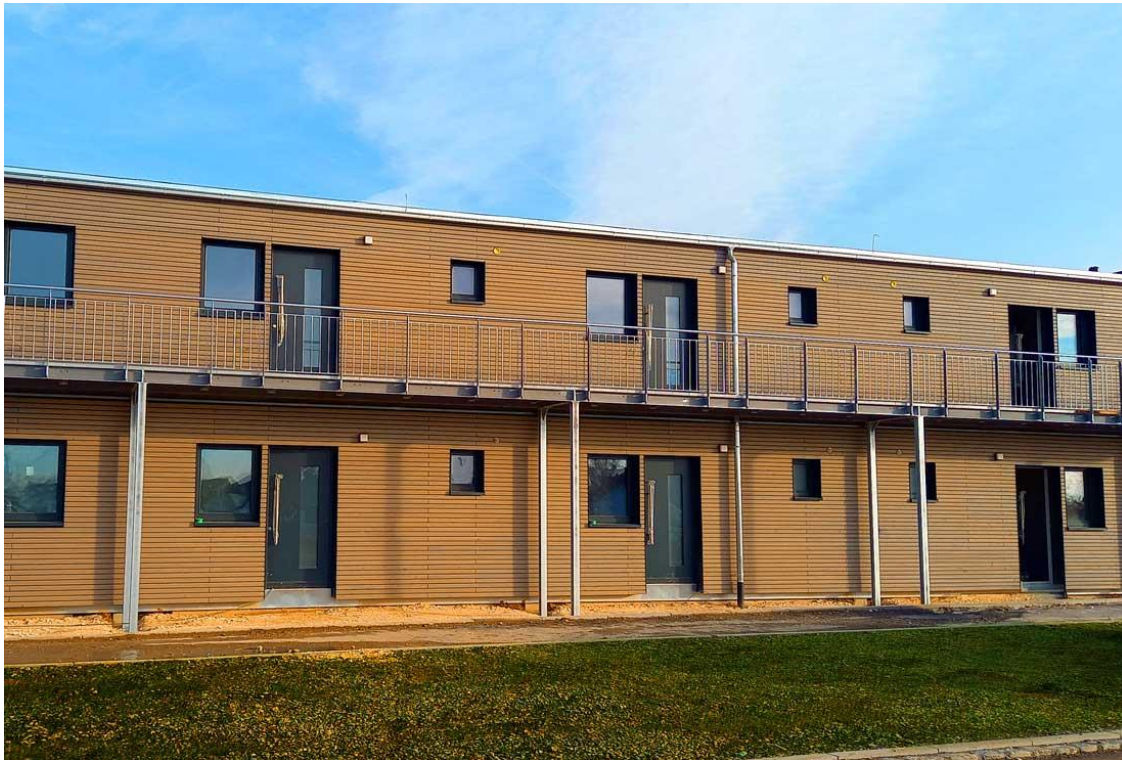
In stahlverstärkter Holz-Modulbauweise errichtet: Flüchtlingsunterkunft in Ulm-Donaustetten. (Bild: Heinkel Modulbau)
